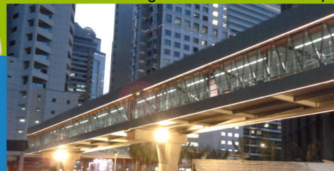
Bukit Bintang-KLCC Pedestrian Walkway
